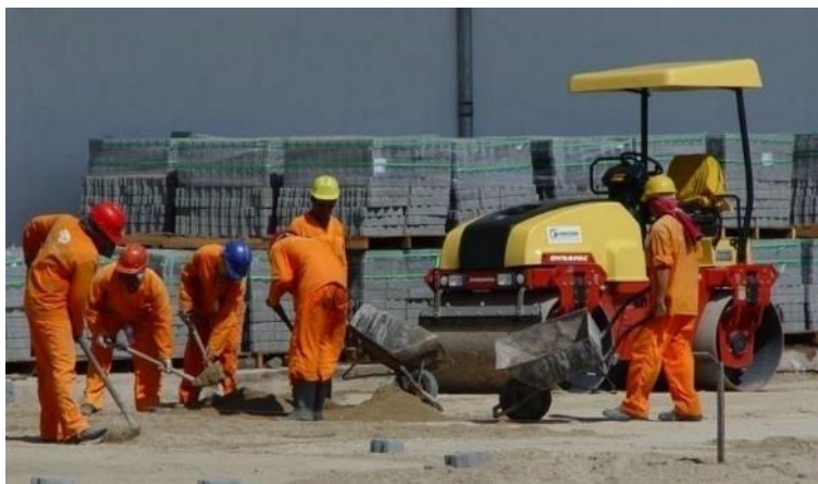
Execução do Pavimento Intertravado
